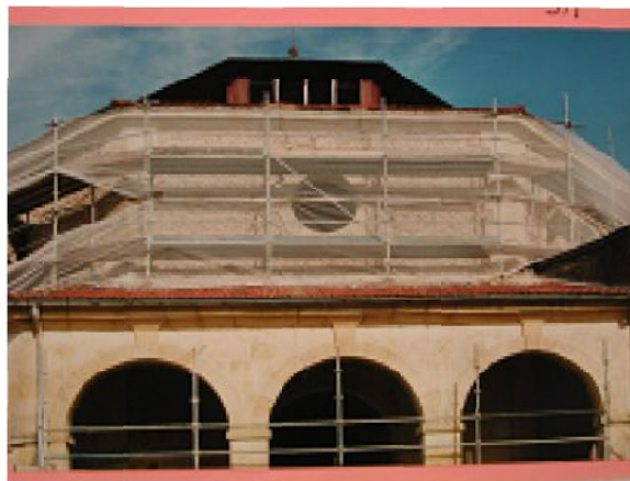
Fig. 20 - Restauration des façades Photothèque de la ville d'Aire
