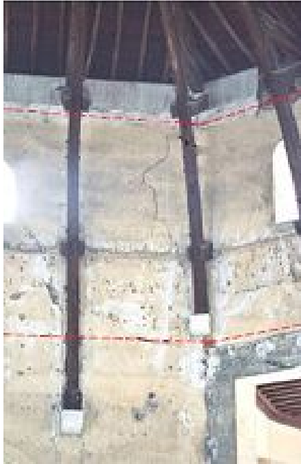
Fig. 21 - Travaux intérieurs. Arch. mun. Aire - Dossier Lavigne
