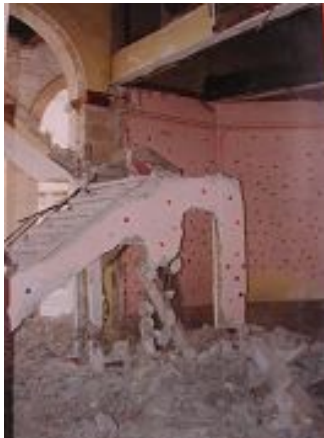
Fig. 19 - Démolition des escaliers menant au balcon et au local de projection Photothèque de la ville d'Aire
